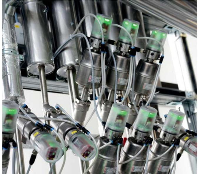
**Vanne à clapet à siège droit**
